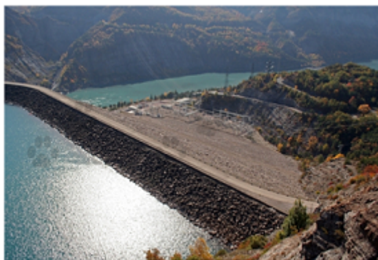
Barrage de Serre-Ponçon, Hautes-Alpes
