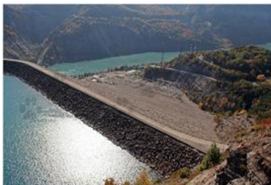
Barrage de Serre-Ponçon, Hautes-Alpes
